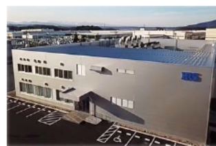
New 一関試験センター
