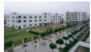
●中国 広瀨電機 (東莞) 有限公司
